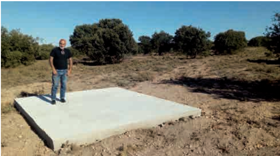
Losa ya construida en el emplazamiento, esperando la impresión del panteón
